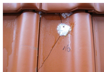
Strešnik po udarcu točnega zrna ekstremne velikosti (2").
